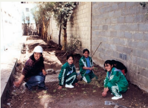
Trabajo colectivo en pro de la construcción de viviendas.
